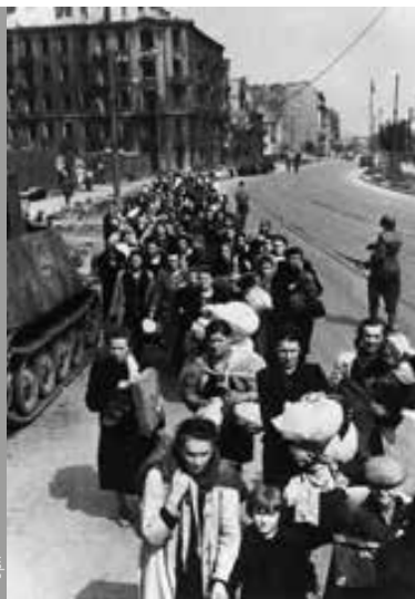
Warschauer-Aufstand: Die Einwohner werden aus der weitgehend zerstörten Stadt deportiert.
